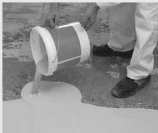
Nivelační hmotu vylijte a vyrovnajte
