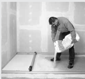
Použití vyrovnávacího podsypu fermacell
