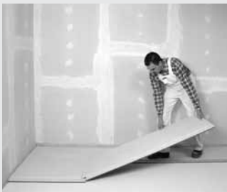
Pokládání podlahových prvků fermacell na vyrovnávací podsyp fermacell
