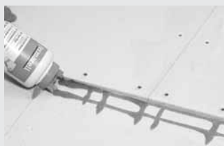
Proužky lepidla na třetí vrstvě fermacell
