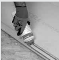
Nanášení podlahového lepidla fermacell do polodrážky
