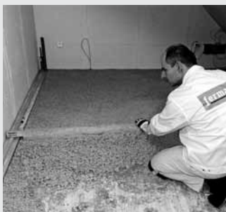
Po provedení nánosu podsypu mezi pásy je nutno jej vyrovnat.
