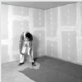
Použití voštinového zásypu fermacell
