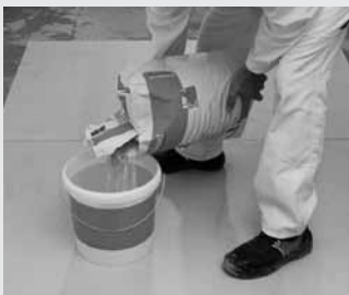
Příprava v čisté nádobě: 6,5 l vody na jeden pytel
