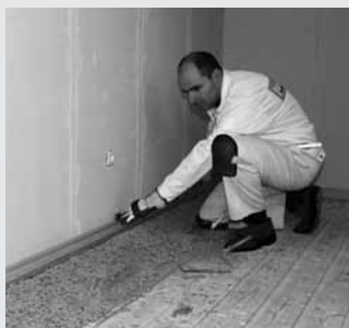
Připraví se první běh pro stahovací lať.
