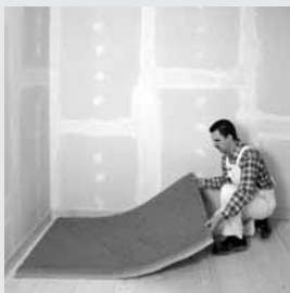
Pokládání podlahové voštiny fermacell
