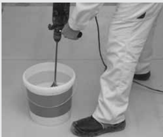
Promíchání vhodným míchadlem při nízkých otáčkách až vznikne homogení, bezhrudková samonivelační hmota
