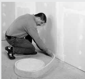
Upevnění krajních izolačních pásek
