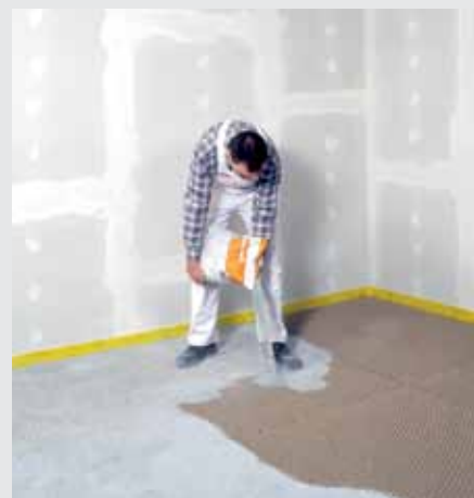
Použití voštinového zásypu fermacell
