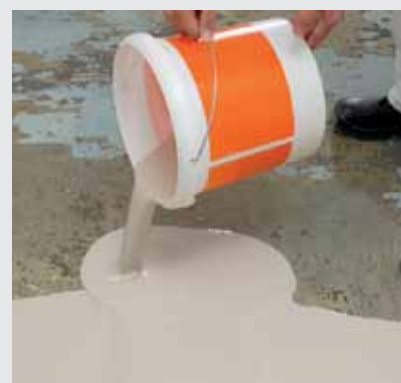
Nivelační hmotu vylijte a vyrovnajte
