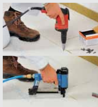
Upevnění pomocí šroubů nebo speciálních rozpěrných sponek... vše do deseti minut po nanesení lepidla.
