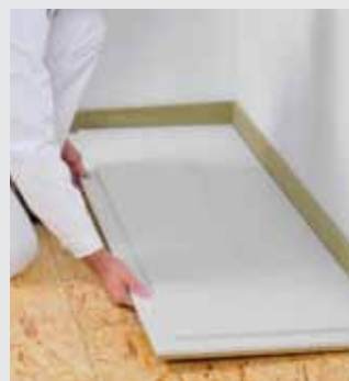
Pokládání podlahového prvku fermacell
