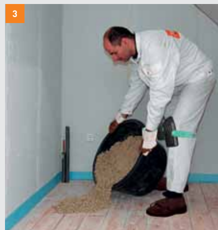
3 Po promíchání vznikne provlhčená směs s konzistencí odpovídající vlhké zemině
