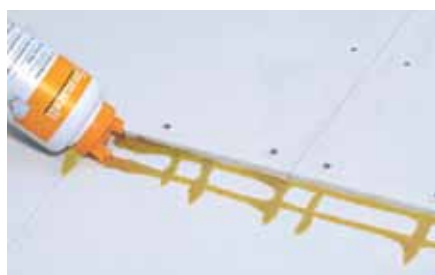
Nanesení lepidla k prolepení 3. vrstvy desek
