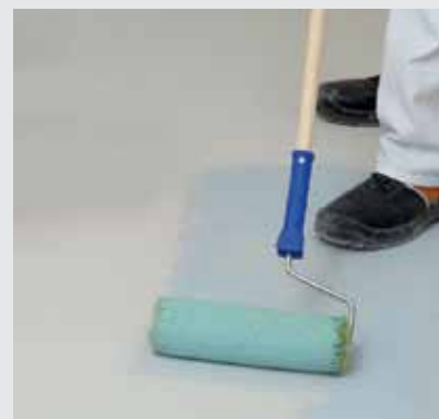
Příprava: penetrace podlahy
