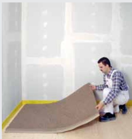
Pokládání podlahové voštiny fermacell
