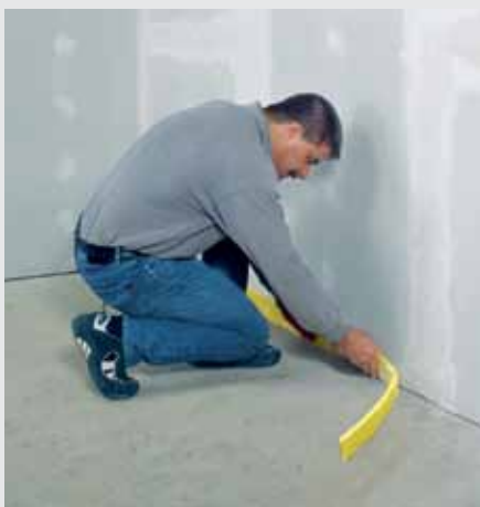
Upevnění krajních izolačních pásek
