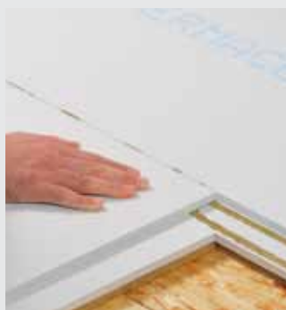
Slepení podlahových prvků
