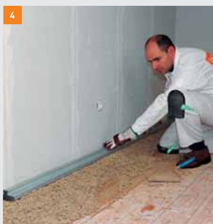
4 Připraví se první břeh pro stahovací lať.
