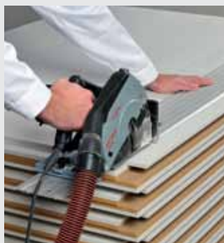
Odříznutí přesahující polodrážky pro první řadu podlahových prvků
