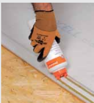
Nanášení podlahového lepidla fermacell na polodrážky
