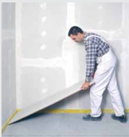
Pokládání podlahových prvků fermacell
