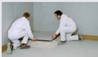
Varianta 1a: ve výši horní hrany korpusu odtoku je celá plocha pokryta rychlotuhnoucím podsypem a poté usazen sprchový prvek
