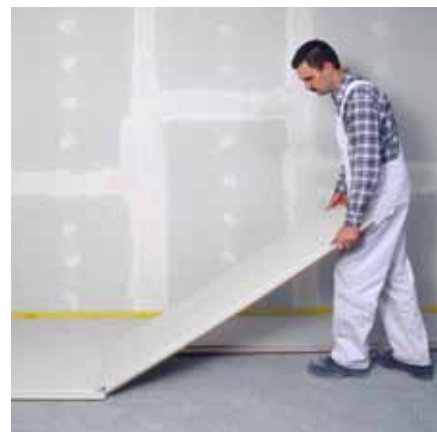
Pokládka akustické desky fermacell Silentio
