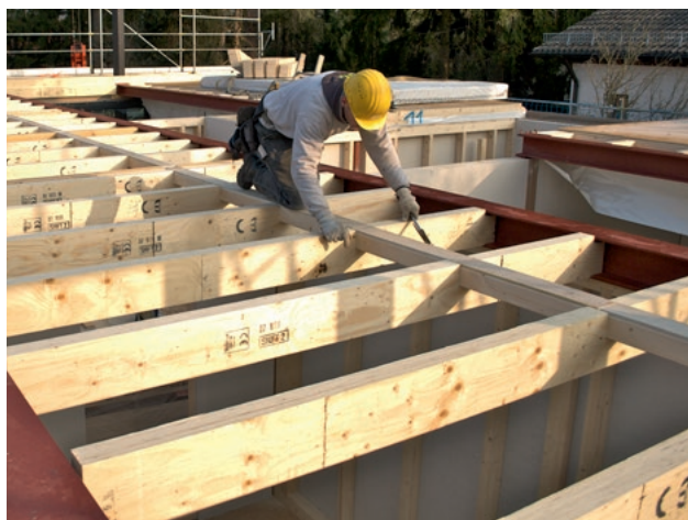
STEICO LVL R u nosné konstrukce stropu
