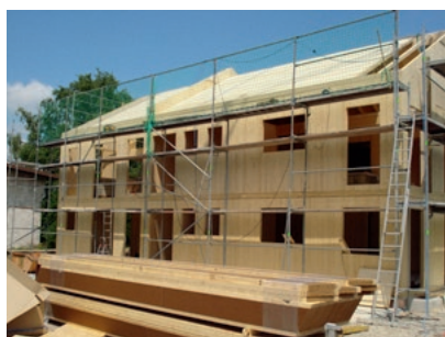
Připravené střešní krokve STEICOjoist čekají na montáž na střeche.
