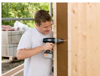
Upevnění nosníků STEICOWall pomocí vrutů přes zadní pásnici.
