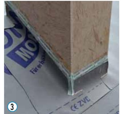
Der obere Anschlussbereich kann zusätzlich mit dem AIRSTOP ULTRA Klebeband rund um den Kamin abgedichtet werden.
