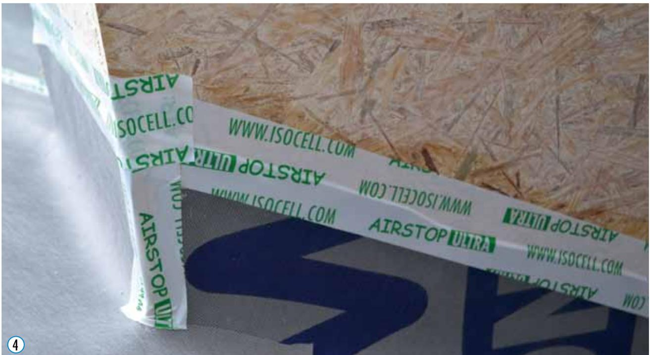
Es können zusätzlich auch alle Kaminecken mit dem Klebeband abgedichtet werden.
