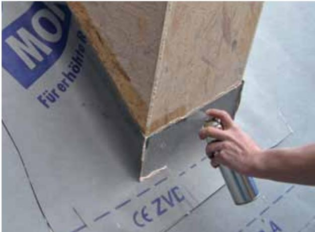
Wird der obere Anschlussbereich mit einem AIRSTOP Klebeband abgedichtet, ist ein Vorprimern (z.B. mit dem UNI Sprühprimer) empfehlenswert.
