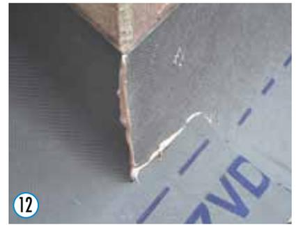
Alle Anschlüsse und Überlappungen im unteren Bereich mit der OMEGA QUILLI Dichtmasse abdichten.
