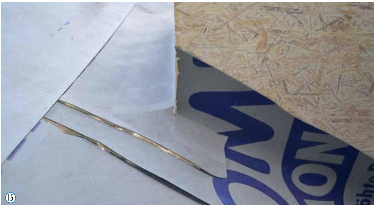
Wasserableitblech anbringen, bzw. ab einer Baubreite von mehr als 1000 mm parallel zur Traufe ist der obere Anschluss mit einem Gefällekeil auszubilden.
