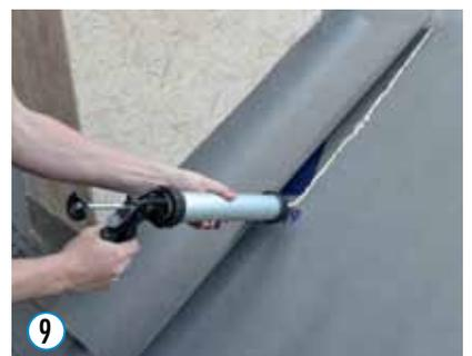
9 Seitliche Anschlussbahn beidseitig auf der Dachbahn regensicher mit der OMEGA QUILLI Dichtmasse abkleben.
