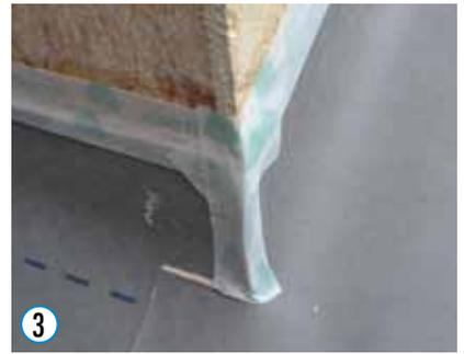
Mit dem AIRSTOP FLEX Klebeband auch alle Ecken abkleben.
