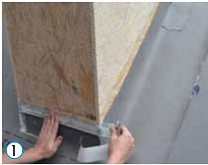
Zusätzlich kann der obere Anschlussbereich mit AIRSTOP FLEX Klebeband abgedichtet werden. Vorher ggf. Primer auftragen.
