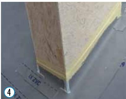
Wahlweise können die mit AIRSTOP FLEX Klebeband abgeklebten Bereiche noch mit der OMEGA LIQUID Dichtpaste überstrichen werden.
