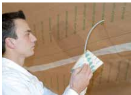
... raum- oder außenseitig auf die luftdichtende Schicht aufgeklebt.
