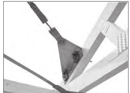
Detail am Traufpunkt: Bandanschluss BNG25 mit Bolzen M12 seitlich am Sparren verschraubt. Bandanschluss BNF25 auf der Unterseite des Untergurtes befestigt.
