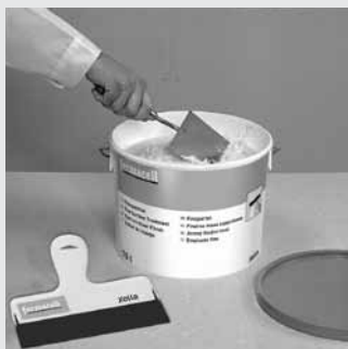
Obr. 38: Plošné stěrkování sádrovláknitých desek fermacell širokou špachtlí fermacell a jemným finálním tmelem fermacell
