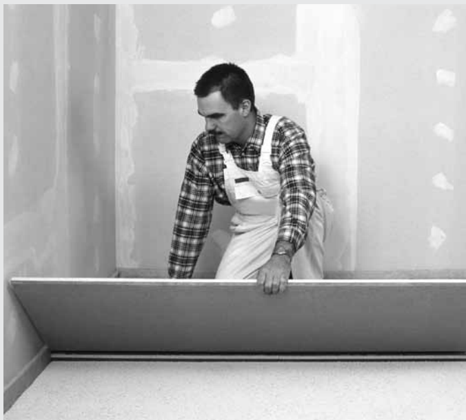
Obr. 43: Kročejová a tepelná izolace podlahových prvků fermacell . Velikost 150 x 50 cm. Dodává se v sedmi různých tloušťkách.
