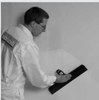
Obr. 38: Plošné stěrkování sádrovláknitých desek fermacell širokou špachtlí fermacell a jemným finálním tmelem fermacell
