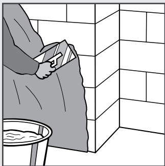
Obr. 18: Při lepení desek na stěny komínů se nanese vrstva lepicí malty fermacell přímo na zdivo a deska fermacell se do lepicí malty zatlačí
