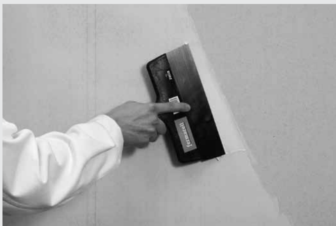
Obr. 39: Flächenspachtelung von fermacell Gipsfaser-Platten
