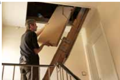
Malý formát: lehké desky formátu 40x120 cm se snadno transportují i malými otvory.
