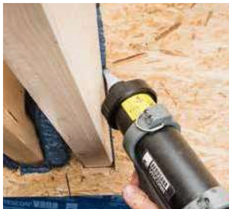
Možnost nanášení linie tmelu k utěsnění spár
