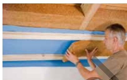
Při této variantě rekonstrukce se neprovádí výměna střešní krytiny a není potřebné ani lešení.
