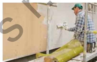
Zateplení fasády dřevovláknitou deskou STEICO*protect* a omít-kou má mnoho předností včetně ochrany před letním horkem. Největší předností proti obvyklému zateplení z polystyrenu je vyšší akumulace tepla v dřevovláknité izolaci, která působí aktivně proti růstu řas a plísni na fasádě. Fasáda se v noci ochlazuje pomaleji, takže vzdušná vlhkost na fasádě nekondenzuje. Je tak zabráněno růstu plísni a řas.
